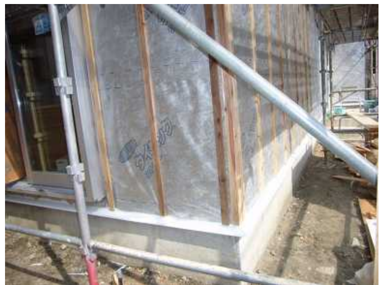
外壁通気工法により躯体内結露を防止します。
