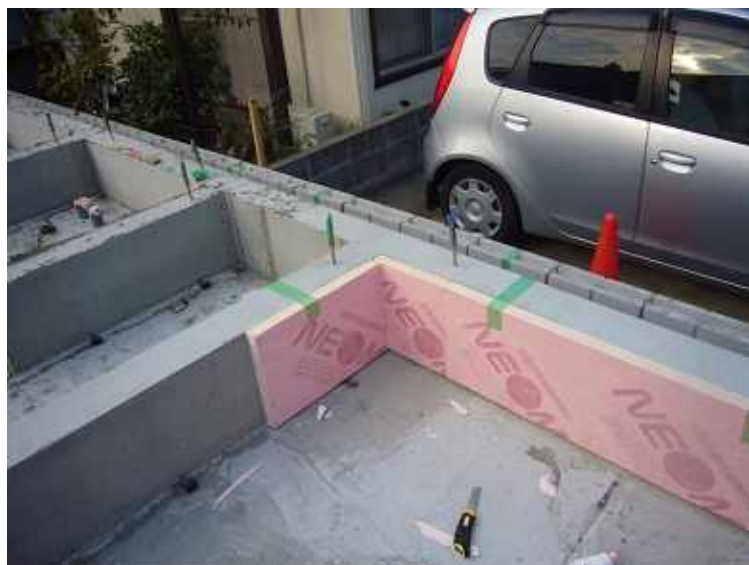
基礎断熱です。
