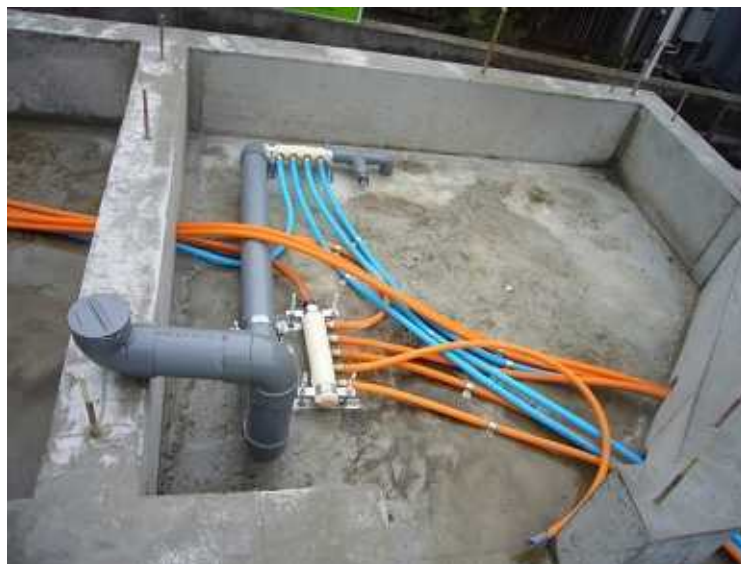
ヘッダー配管です。後のメンテナンスが容易です。
