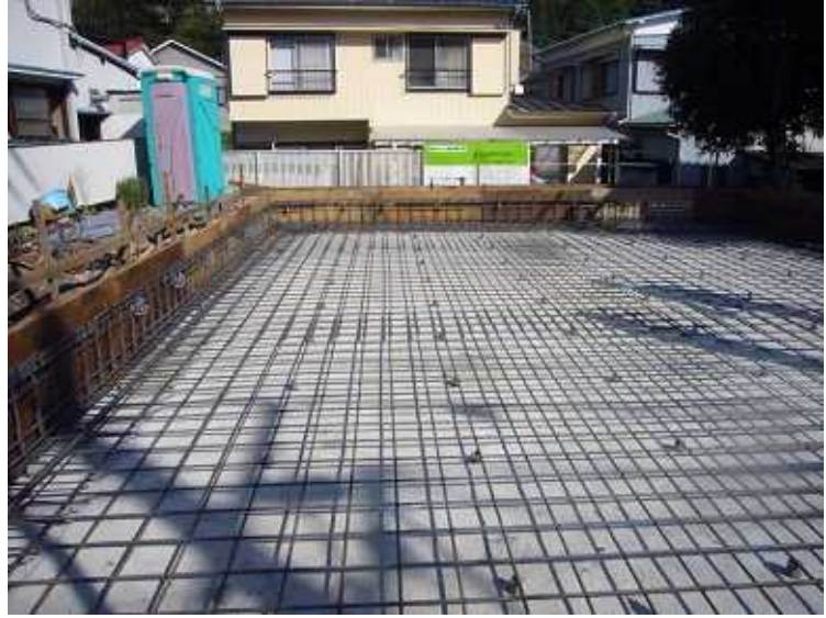
鉄筋の配筋状況です。
