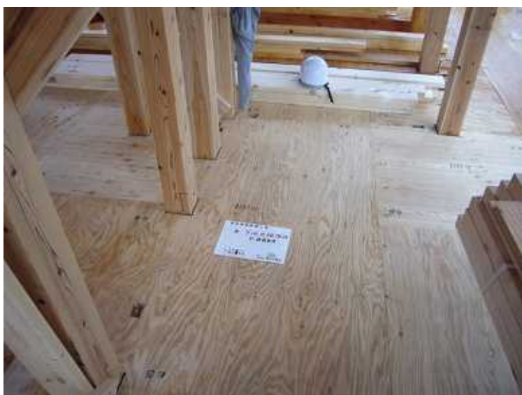
2階床 根太レス工法です。
