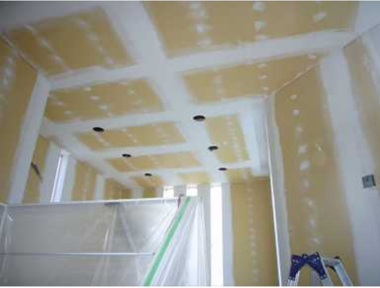
石膏ボードの継ぎ目をしっかりとパテ処理中。
