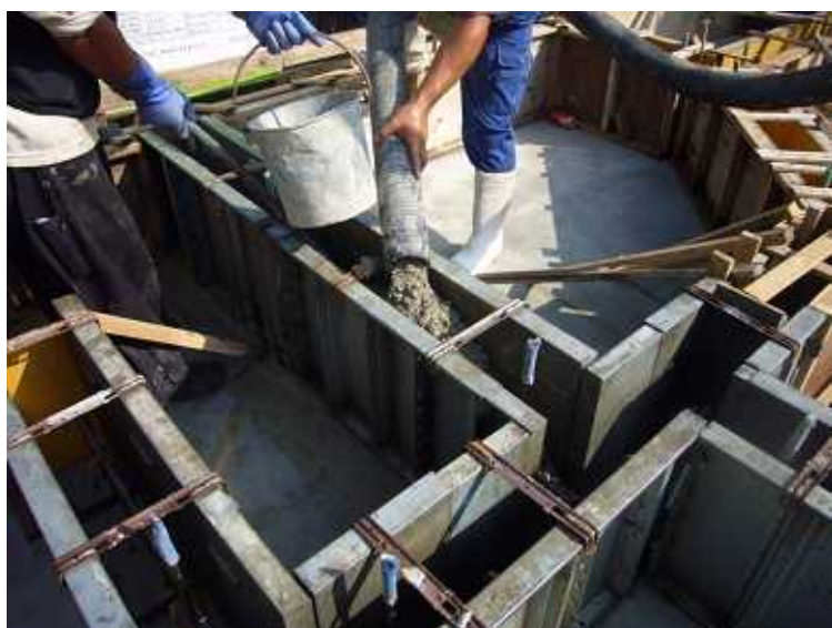
コンクリートの打設状況です。
