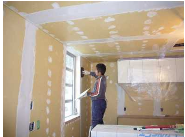
石膏ボードの継ぎ目をしっかりとパテ処理中。
