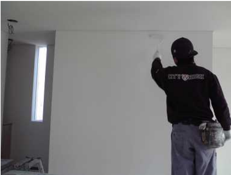
内壁塗装仕上げの様子。
