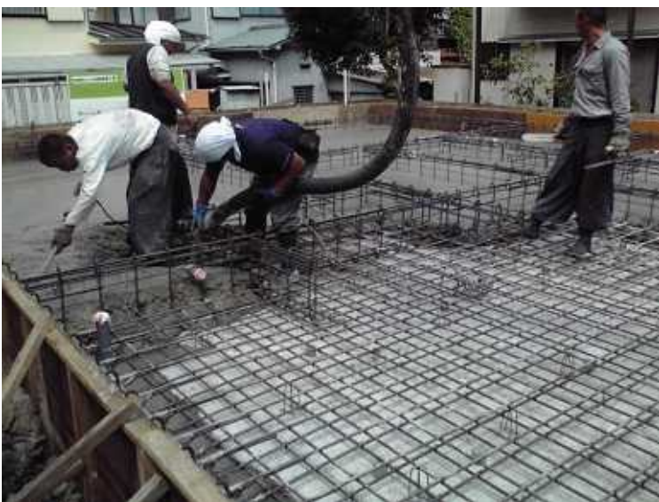
コンクリートを打設しています。
