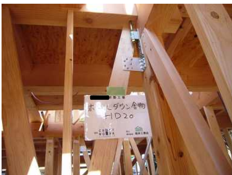
接合部にはしっかり金物で補強。
